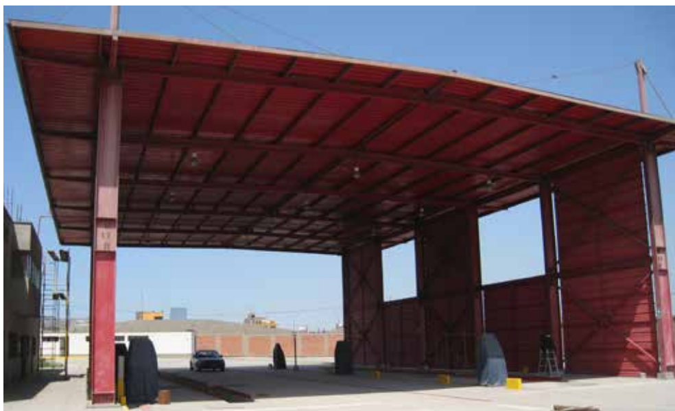
Planta de inspecciones técnicas vehiculares del INTRAFIM
